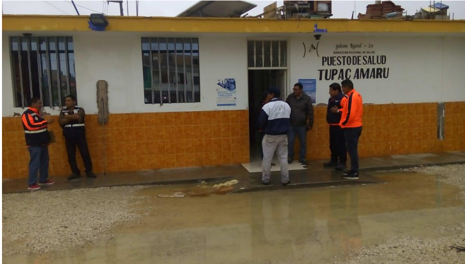
Afectación en el P.S.S Túpac Amaru
