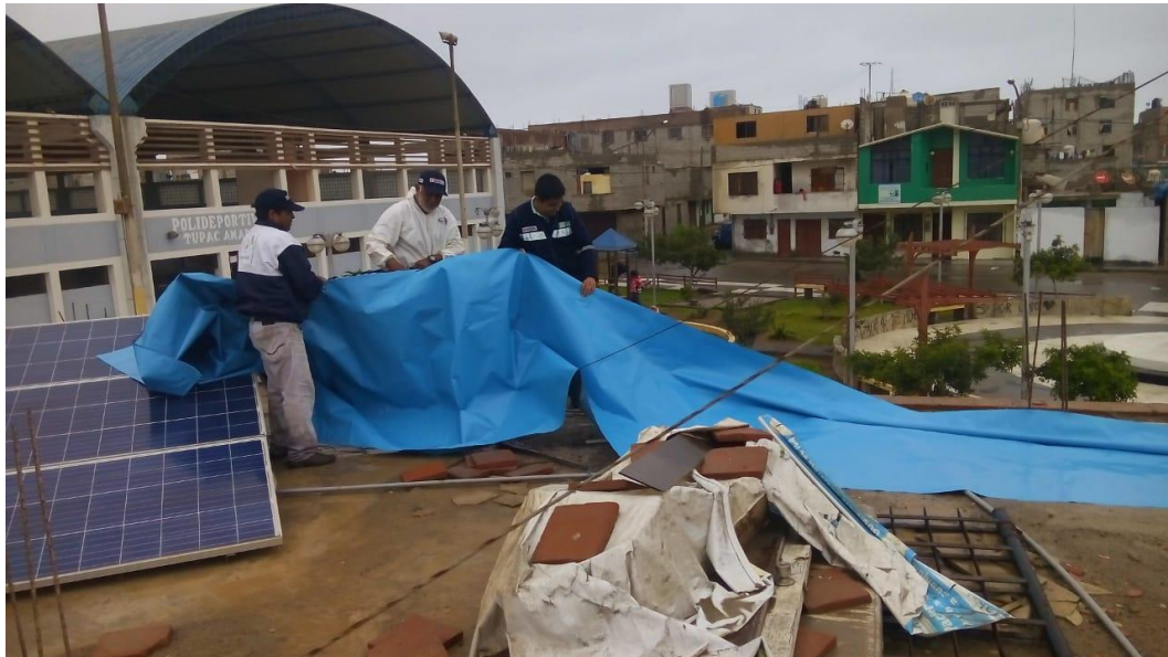
Personal realiza la cobertura de techo P.S. “Túpac Amaru”
