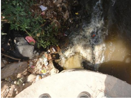
Fotografía N° 5 – Punto de ubicado entre el Puente Tingo y Discoteca Kilombo
