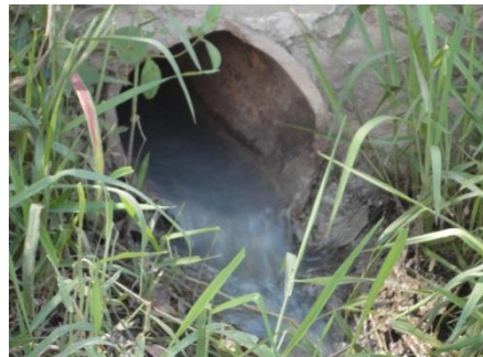
Fotografía N° 11 – Salida del Agua Residual del Instituto Superior Tecnológico Aparicio Pomares. .
