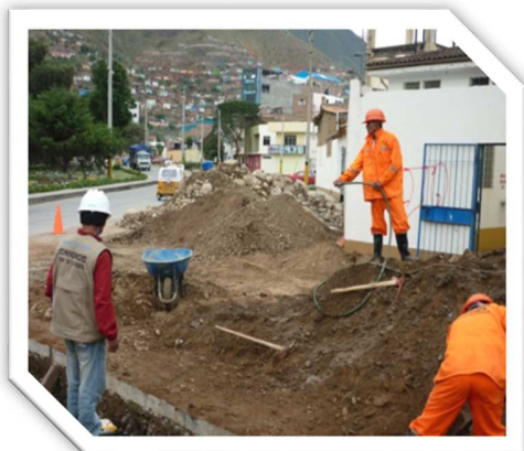
Fotografía N° 02. Riego de los escombros y montículos de tierra.
