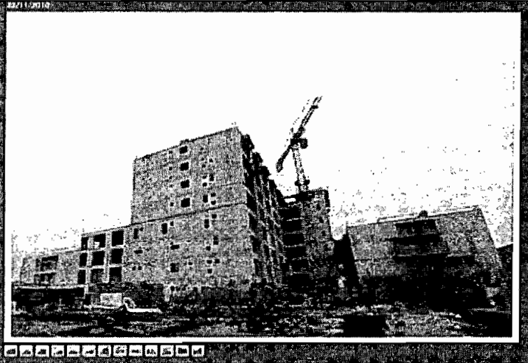
NUEVO INSTITUTO SALUD DEL NIÑO EN EL TERCER NIVEL DE ATENCION 8V DE COMPLEJIDAD, CATEGORIA III-2B
