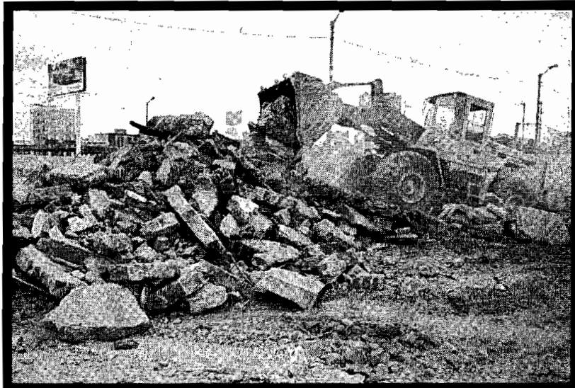
Obras en el Nuevo Hospital Nacional de Salud del Niño ubicado en San Borja
