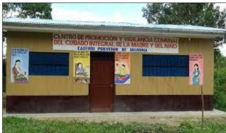
Fuente: Informe DGPS
